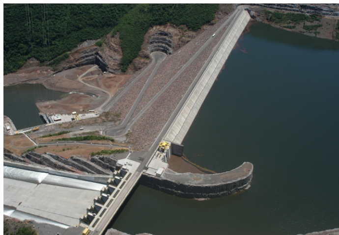
Barragem e demais estruturas civis da Usina Hidrelétrica Barra Grande estão em plenas condições de operar com segurança
