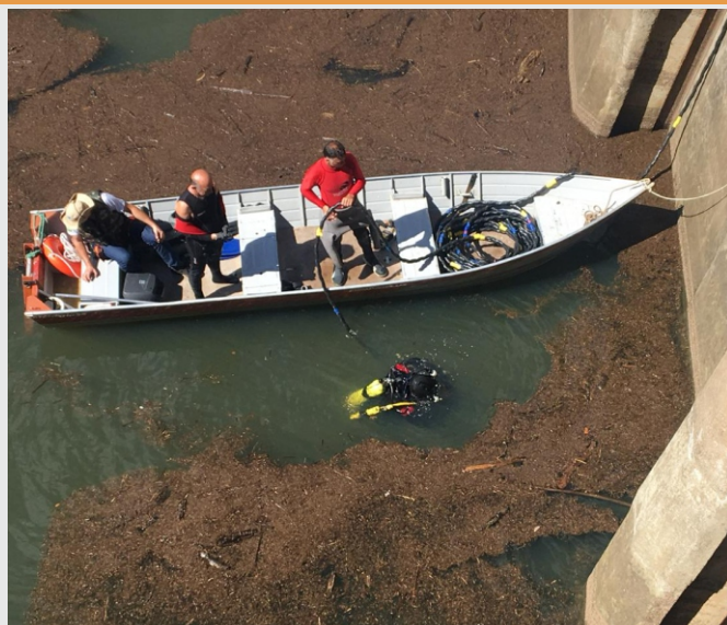
Inspeção aquática é realizada periodicamente para avaliar o estado de conservação das grades das Unidades Geradoras da Usina
